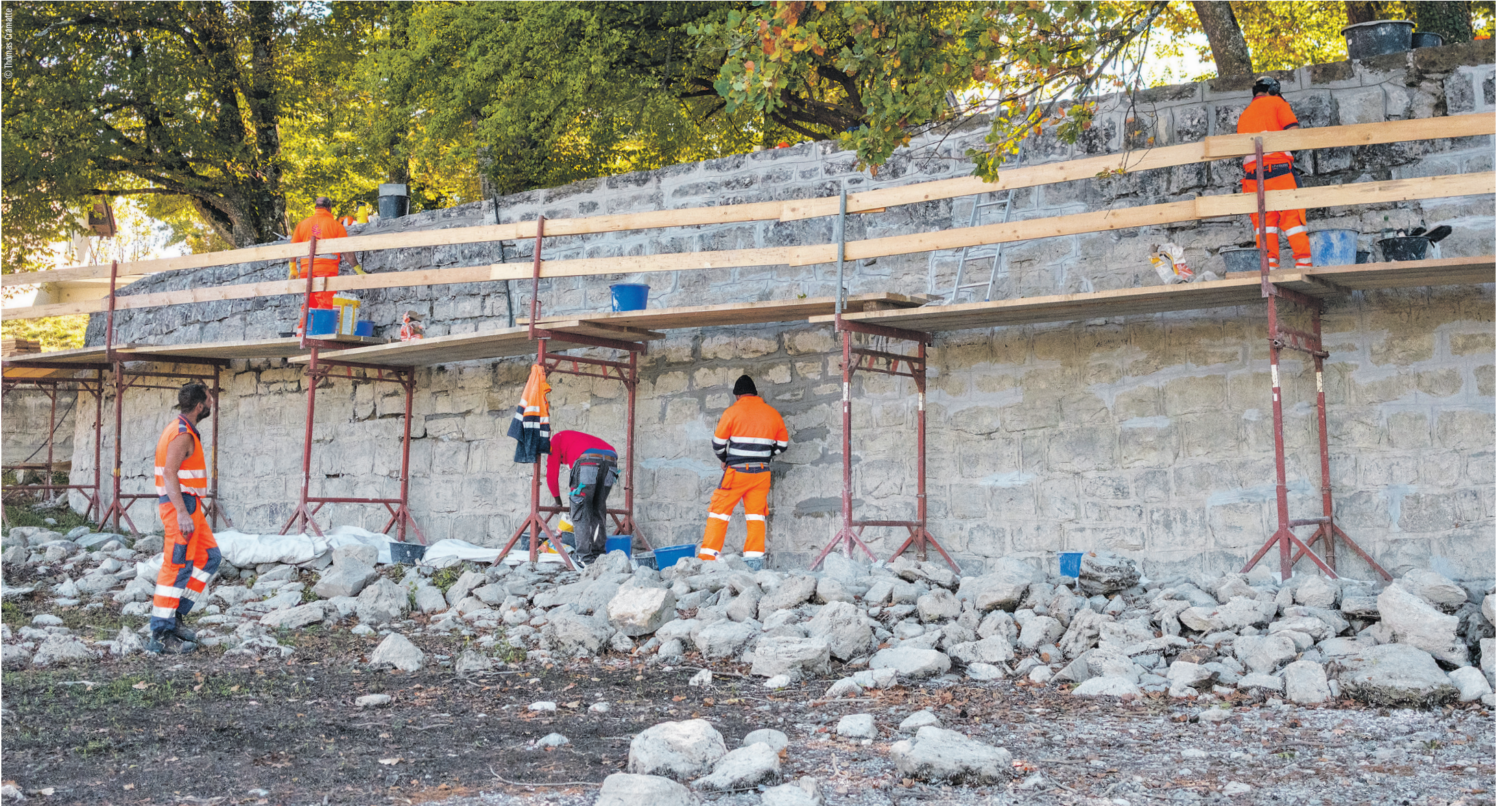
Les ouvriers sondent les joints du mur en moellons à coups de marteau. Ceux qui sonnent creux sont retirés, puis refaits à neuf
