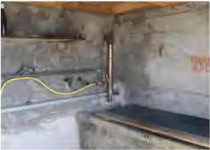
La capite de La Corsaline est une construction modeste dont les fonctions principales étaient de ranger les outils et de récupérer l'eau de pluie
