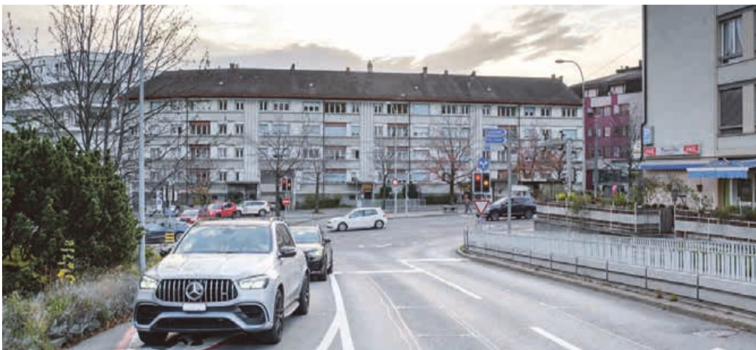
Sur l'avenue de Lavaux et la place de la Clergère, la question n'est plus de savoir s'il faut agir, mais comment concilier sécurité, accessibilité et fluidité du trafic
