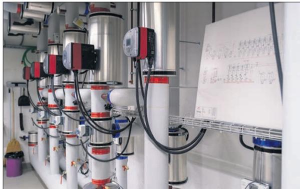
L'intérieur du nouveau bâtiment du collège d'Oron, construit en 2021. Ce système centralisé permet de chauffer l'ensemble des quatre bâtiments depuis deux chaudières. C'est ce que l'on appelle, un chauffage à distance
