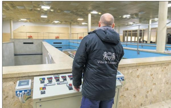
Actuellement, les travaux de rénovation incluent la réfection des revêtements des bassins (ici à gauche), ainsi que le remplacement des filtres à sable et à charbon.
