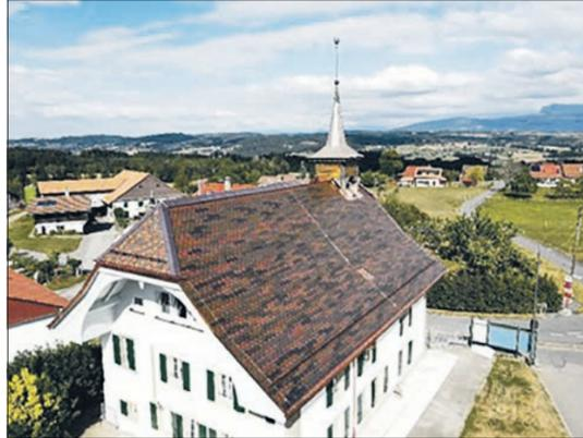
Toiture en tuiles solaires photovoltaïques du collège de Ferlens
