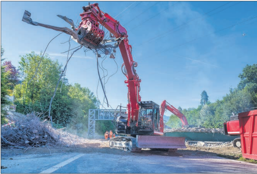
Démantèlement entre ferraille et béton
