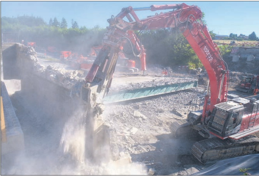
Si la nouvelle passerelle sera installée en novembre prochain, il ne faut pas s'attendre à une réouverture de la route avant l'été 2025. Car des travaux dans la zone forestière suivront ceux de l'OFROU
