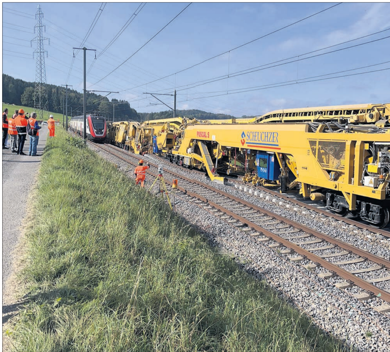
Le train mobile qui remplace la structure
