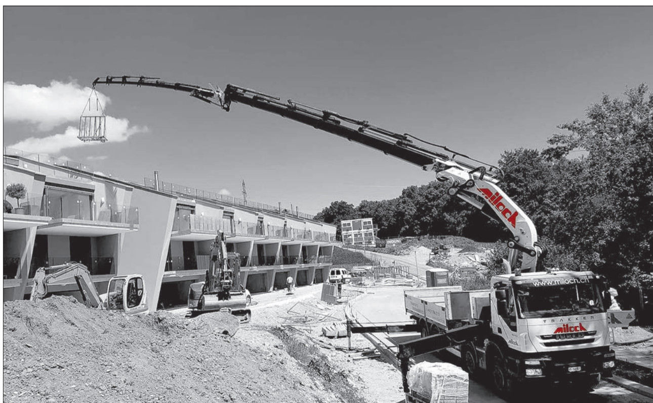
En matière de levage, la société compte une flotte de huit camions grues avec la possibilité d'atteindre une hauteur de 60 mètres
