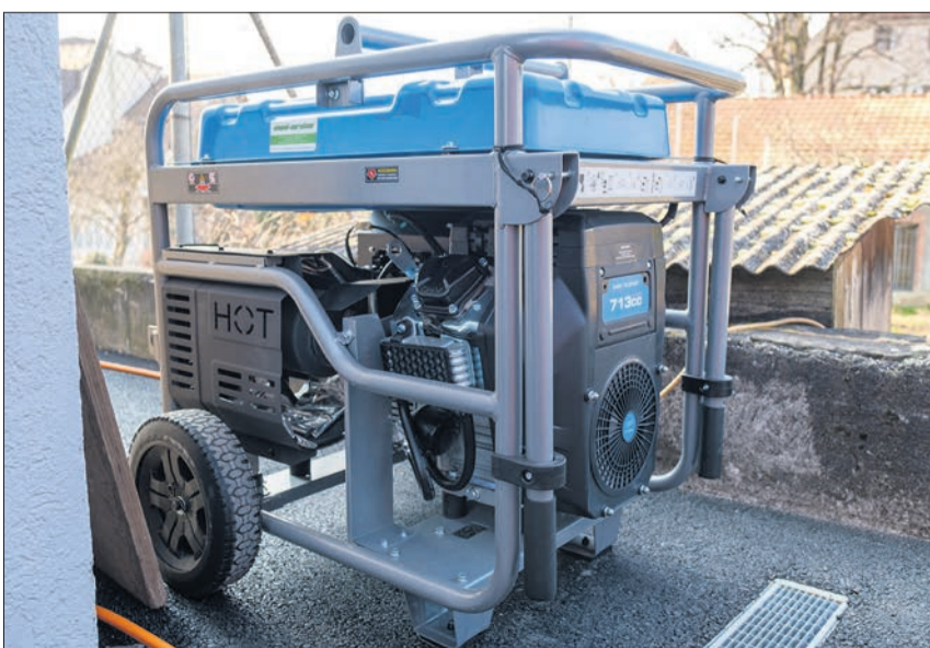
Lutry a réalisé, le jeudi 2 mars, un test de son PRU situé à la route de Lavaux 208. L'alimentation en électricité de ce lieu pourra être assurée par une génératrice en cas de besoin.
