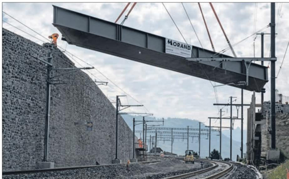
Un ouvrier adapte les appuis de la passerelle avant de la fixer sur le nouveau mur de soutènement
