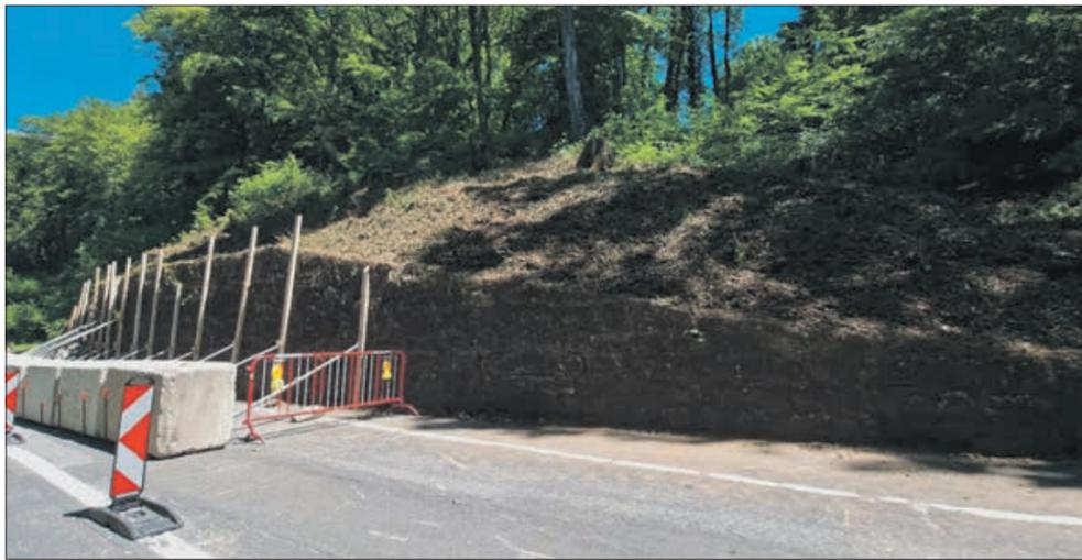
Dans la nuit du 10 mai, une partie du mur de soutènement de la route cantonale RC 773 reliant Belmont-sur-Lausanne à Pully s'est effondrée, obstruant la moitié amont de la chaussée. Les services compétents ont immédiatement pris les mesures nécessaires pour sécuriser la zone et mis en place une régulation du trafic par feux. Des étais ont aussi été installés sur toute la partie encore intacte du mur et plusieurs gros arbres ont dû être coupés, nécessitant d'importants moyens de bûcheronnage
