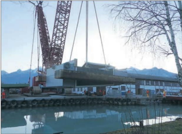
Mise à l'eau du pont le vendredi 26 mars au Bouveret avec une grue qui peut soulever jusqu'à 1000 tonnes !
