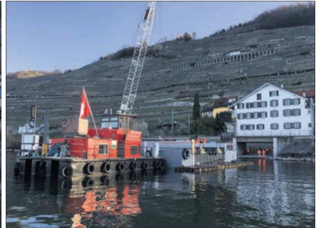
Le pont immergé avec les caissons de flottaison qui l'ont stabilisé durant le transport avec la barge qui l'a poussé depuis le Bouveret
