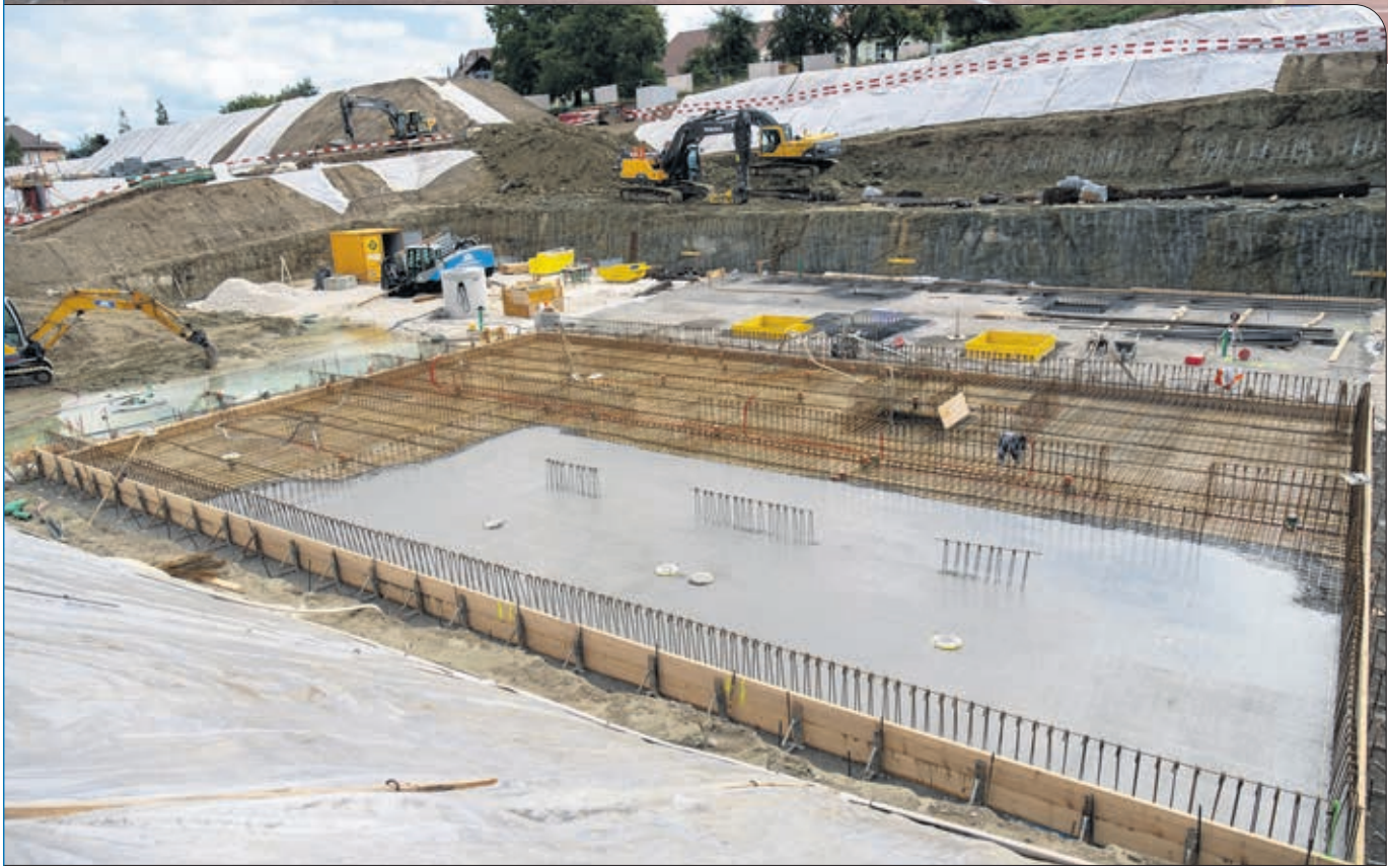
Les fondations au 1 er septembre
