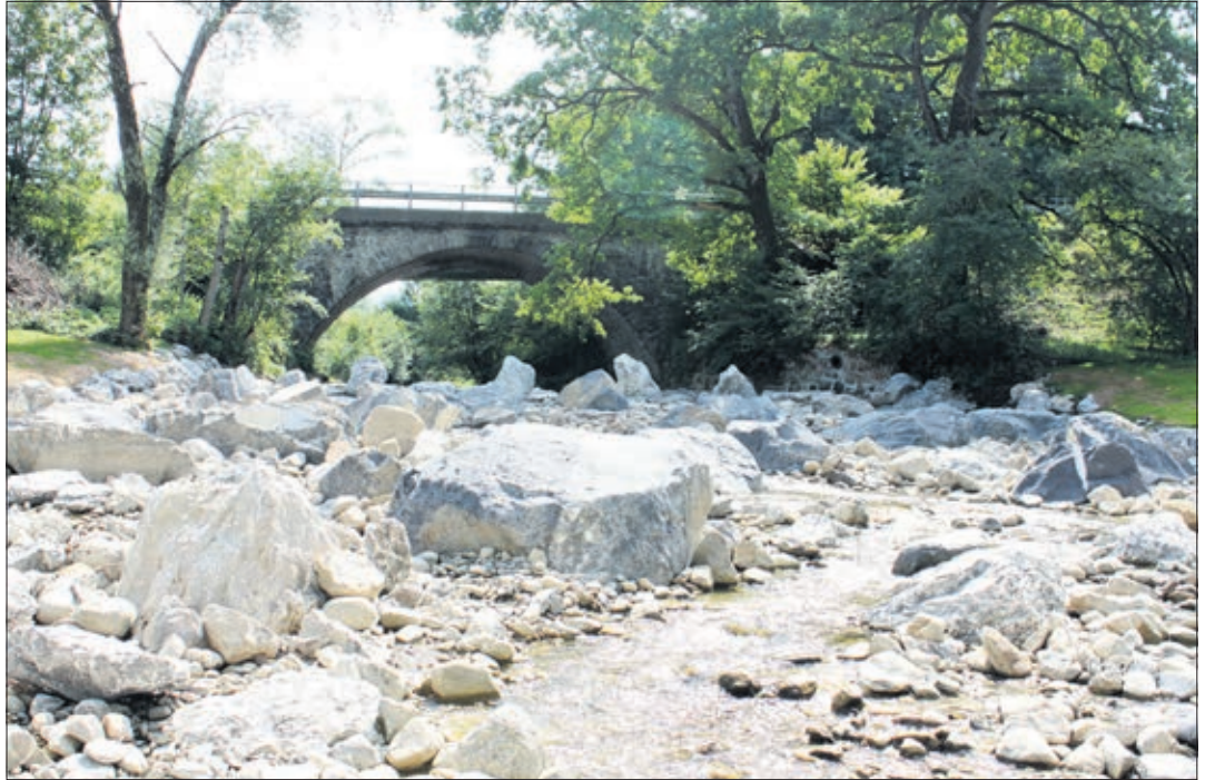
Après les travaux
